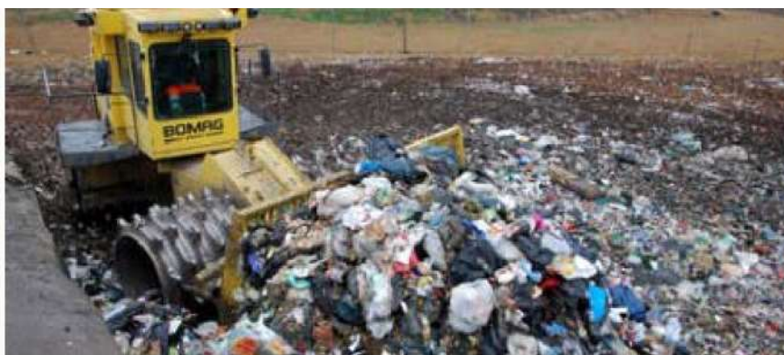
Figure 5 Compaction des OMR* sur les casiers de stockage
